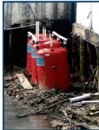
Perakitan SPTDP di lokasi yang sudah selesai
