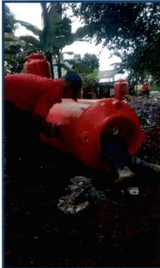
Proses perakitan SPTDP di lokasi
