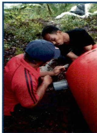
Proses perakitan SPTDP di lokasi
