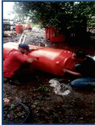
Proses perakitan SPTDP di lokasi
