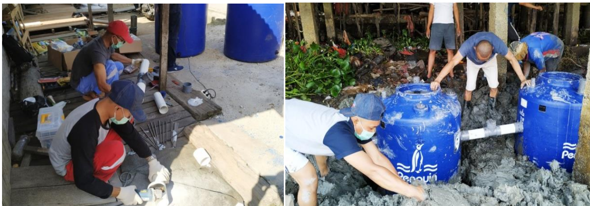
Pembuatan dan pemasangan SPTDP
