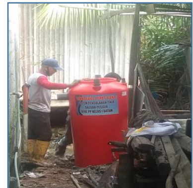
Perakitan SPTDP di lokasi yang sudah selesai
