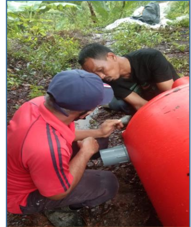
Proses perakitan SPTDP di lokasi
