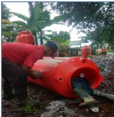
Proses perakitan SPTDP di lokasi
