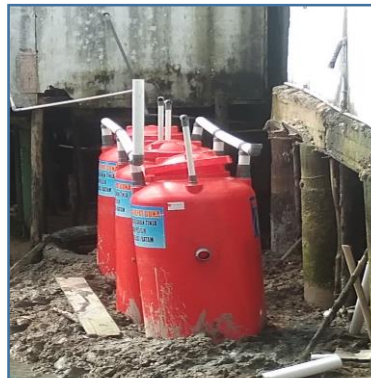
Perakitan SPTDP di lokasi yang sudah selesai
